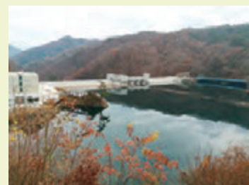
利根川の支流・吾妻川流域に建設された八ッ場ダム。令和2年3月に完成しました
