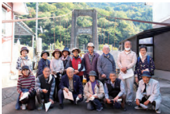
大川橋とともに。11月には撤去作業が始まりました
