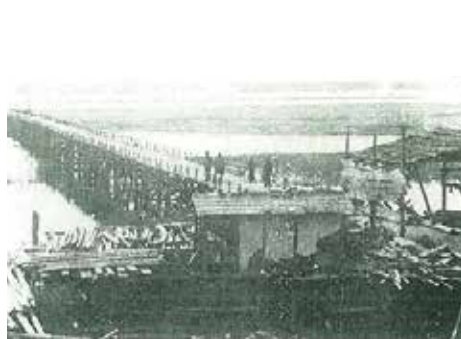
大正7年頃の古川橋。木製で洪水のたびに流されています。「古川貫取り橋」とも呼ばれていました。(写真集「吉野川百年史資料編」)
