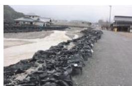
復旧作業が少しずつ進む
