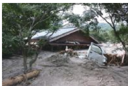
土砂に埋もれた家屋
